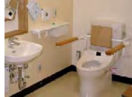
【手摺りつきトイレ】
