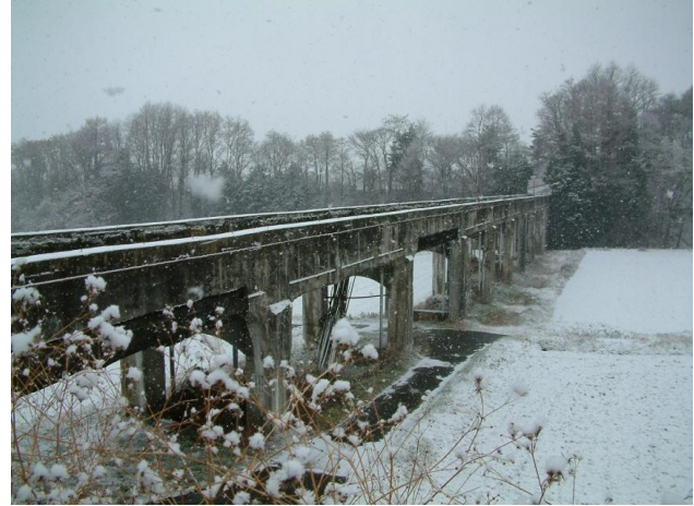
八乙女の水路橋(箕輪町)
