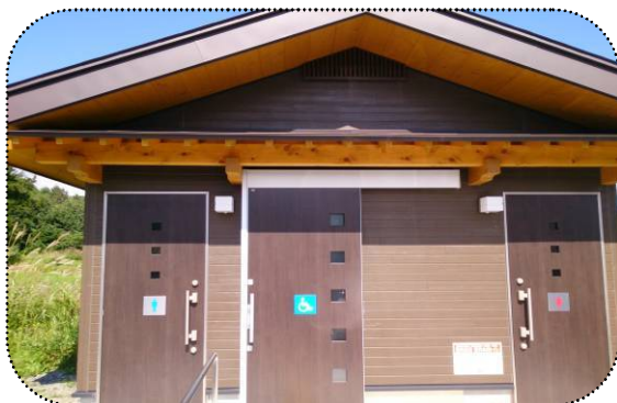
○木曾町 [開田高原 管沢公衆トイレ]
