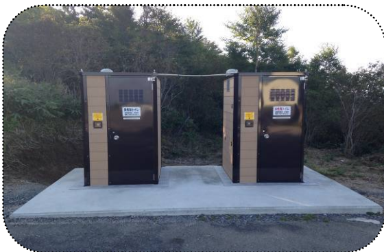
○平谷村 [高嶺山バイオトイレ]
