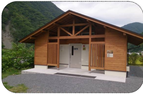
○大鹿村 [ビガーランド公衆トイレ]
