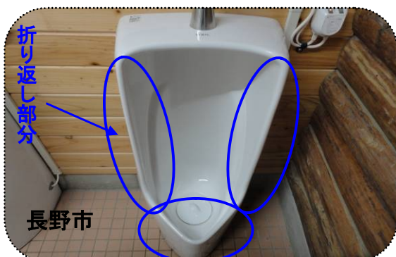
○清掃しやすい小便器が設置されている。⇒汚れが付きやすい [折り返し] がない。手すりが設置されている。
