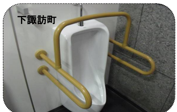
○清掃しやすい小便器が設置されている。⇒汚れが付きやすい [折り返し] がない。手すりが設置されている。
