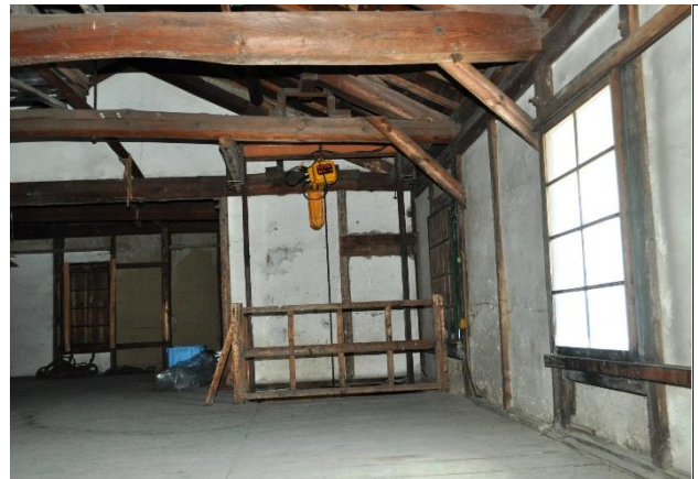
寿高原食品四階倉庫 内部
