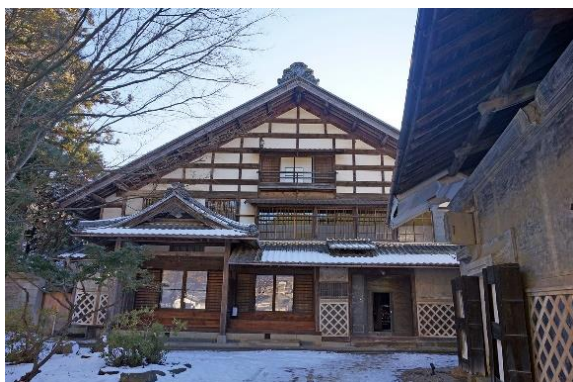
旧小澤家住宅主屋（外観 北面 北より見る）
