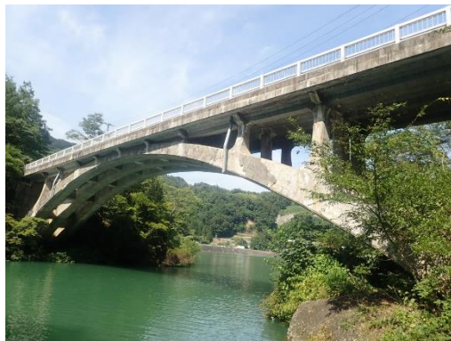
久米路橋（橋梁下部より全景）
