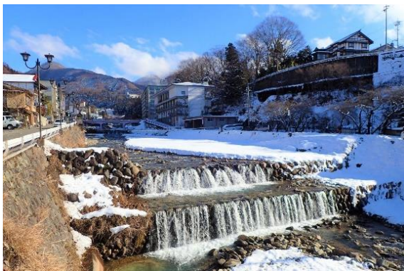
横湯川第三九号堰堤（正面 右岸側より望む）
